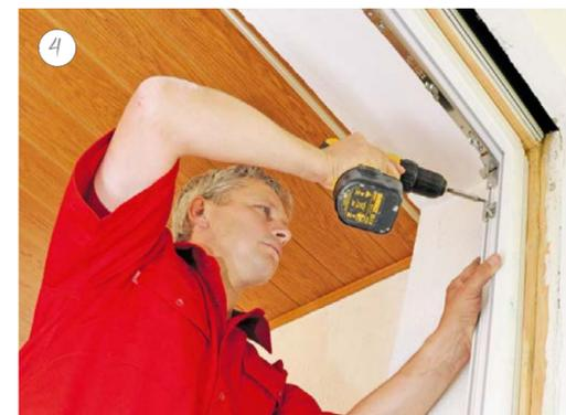
Der neue Fensterrahmen wird an mehreren Stellen sicher verschraubt.
