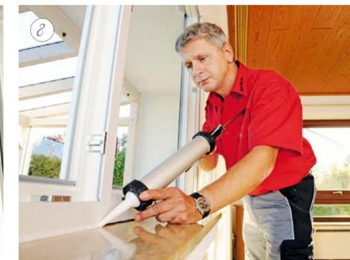
Abschließend wird der Anschlussbereich des neuen Fensters ringsum ausgefügt.
