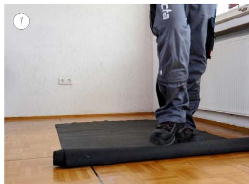
Im Arbeitsbereich werden schützende Matten auf den Boden gelegt. Dann erst werden die alten Fensterflügel ausgehängt.
