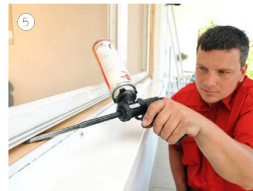
Der Zwischenraum von altem Fensterrahmen und neuem Rahmen wird wärmedämmend mit FCKW-freiem Polyurethanschaum ausgeschäumt.
