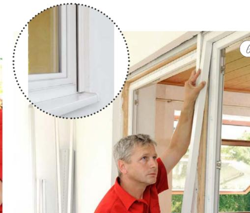
Der äußere Fensterrahmen wird aufgesetzt und durch ein spezielles Aufnahmeprofil fest mit dem inneren Rahmen verbunden. So können auch große Elemente mit dem perfecta System problemlos erneuert werden.
