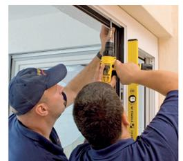
Alter und neuer Türrahmen werden miteinander sowie mit dem Mauerwerk passgenau verschraubt. (Foto: epr/perfecta) 007 02
