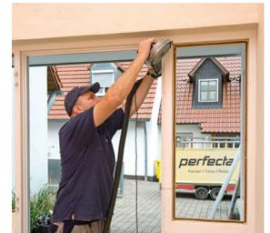
Mit einer Spezialsäge entfernen die Monteure behutsam den Großteil des alten Türrahmens. (Foto: epr/perfecta) 007 02
